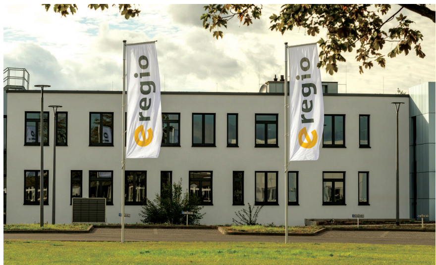
Die e-regio GmbH & Co. KG aus Euskirchen bietet ihren Kunden eine digitalisierte Abwicklung bei der Installation von Hausanschlüssen. Bild: e-regio
